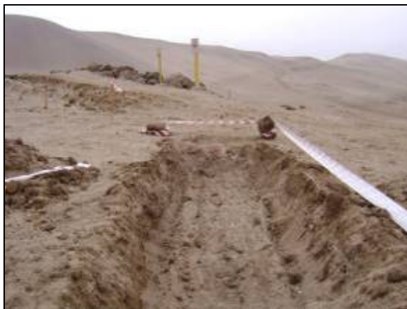
Señalización en frentes de obra
