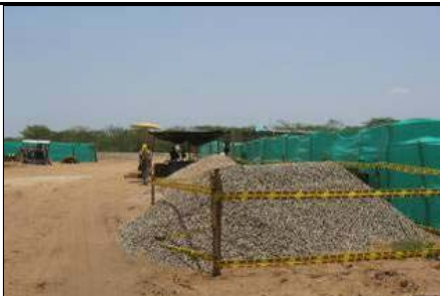
Actividades de señalización de sitios temporales de acopio de materiales
